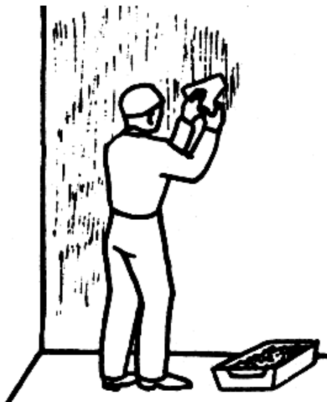
Рис.6. Шлифовка подмазанных мест
