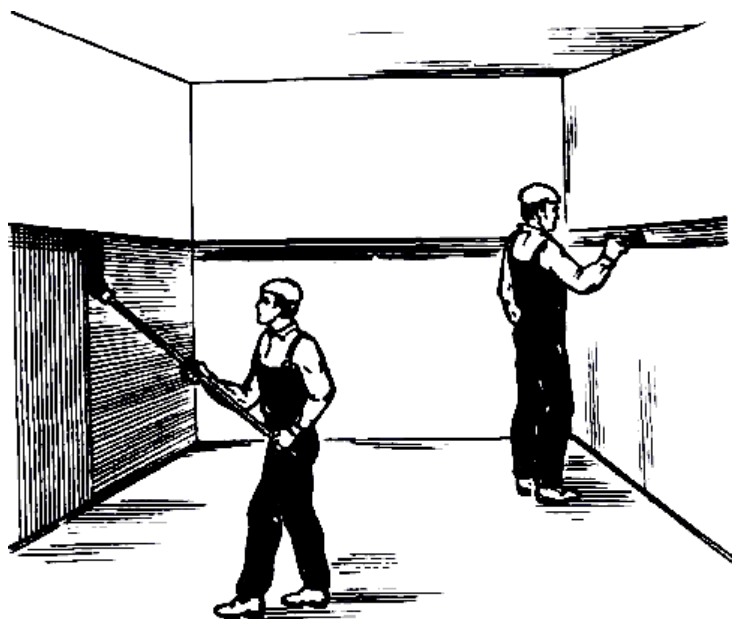
Рис.21. Проолифливание поверхности маховой кистью с отводкой верхней границы кистью-ручником
