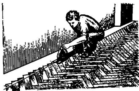
Рисунок 2. Обрезка циркулярной электропилой концов крайнего ряда и клепки по линии прижимания к линейке фриза
