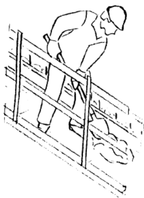
Рис.6. Очистка лопатами просыпавшегося бетона с деревянного настила подмостей и опалубки
